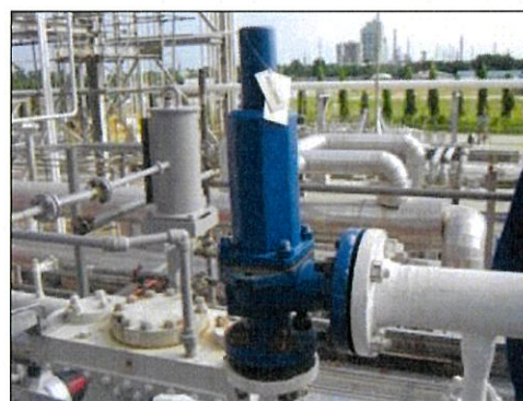
ภาพที่ 2.2-24 ระบบวาล์วนิรภัย (Safety valve)
