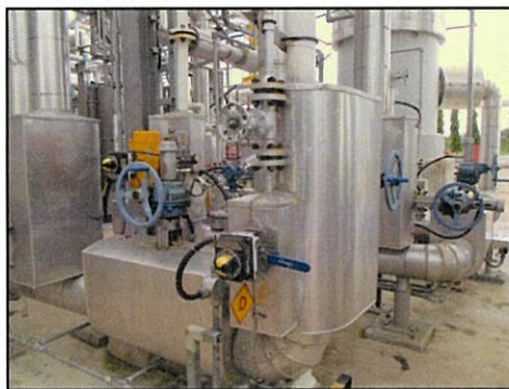
ภาพที่ 2.2-27 ระบบแจ้งเตือนเมื่อพบความผิดปกติของอุณหภูมิภายในถังที่ทำการฟื้นฟูสภาพสารดูดซับ
